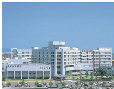
■ 熊本中央病院 熊本県熊本市
